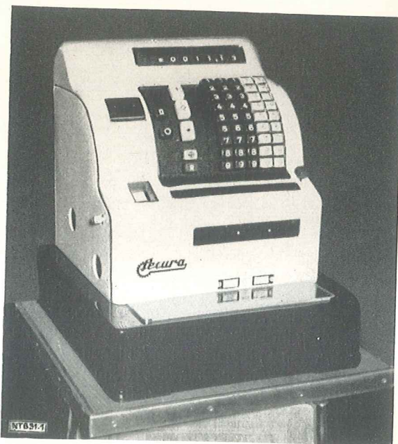
Bild 1. Aufrechnungskasse vom VEB Secura-Werke für Selbstbedienungsläden
