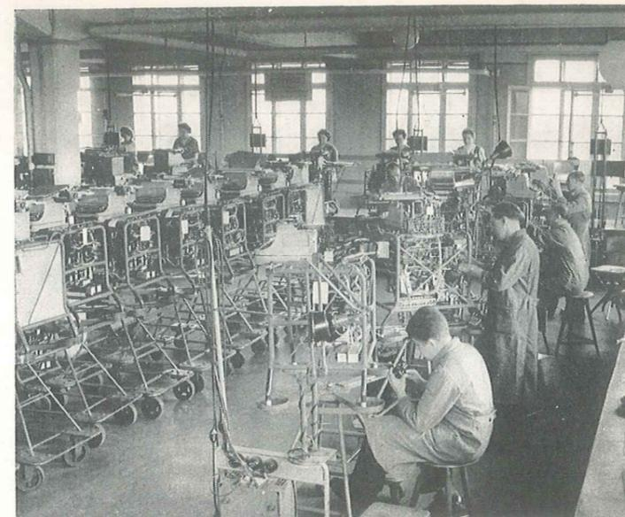
Bild 8. Fakturiermaschinen-Endkontrolle bei Rheinmetall, Teilausschnitt
