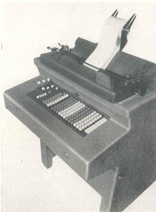
Bild 2. LOGABAX-Statistikmaschine Modell S 210
