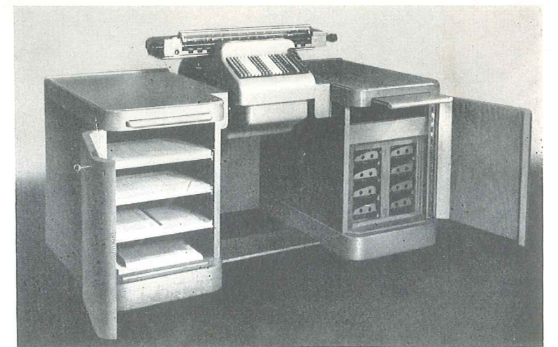
Bild 1. Optimatic-Buchungsautomat Modell 922 im modernen Schreibtisch
