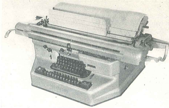
Bild 2. SR 42 mit CL-Vorsteckeinrichtung (mit 1 Antriebsrad und 2 Querwerken)
