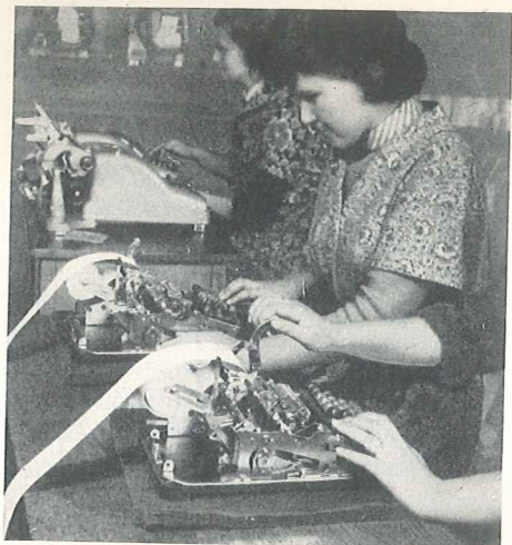
Bild 3. Die Saldiermaschine Typ 160 in der individuellen Schlußkontrolle
