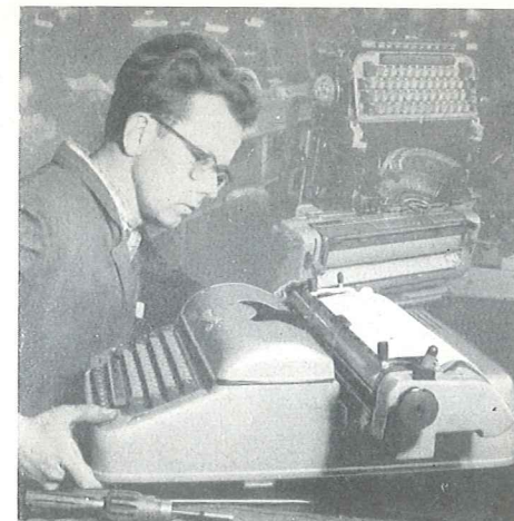
Bild 9. Aufsetzen der Verkleidung als letzte Operation in der Fertig-Montage der GSE
