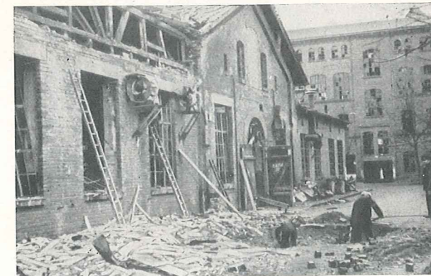
Bild 1. Zerstörte Betriebsteile des heutigen VEB Optima, Erfurt
