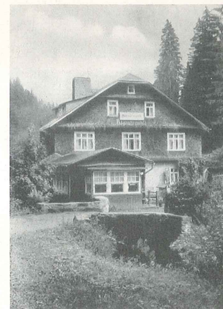
Bild 14. Ferienhaus Massermühle des VEB Büromaschinenwerk Sömmerda in der Nähe von Masserberg
