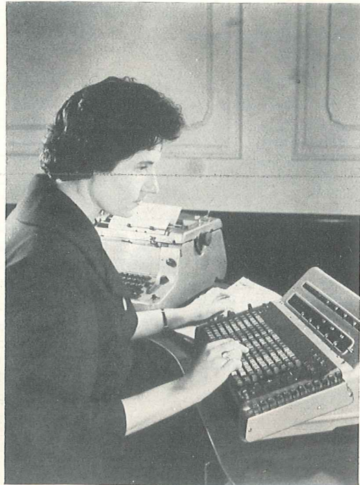
Mercedes Multiscript KRS 444, eine Maschinenkombination von Rechenautomat R 44 SM mit elektrisch angetriebener Schreibmaschine SE 4
